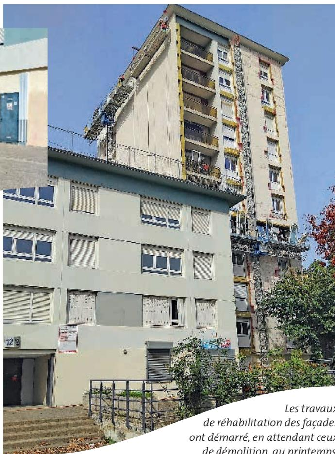
**A**ctuellement, les ouvriers de l'entreprise Eiffage, missionnée par la SDH, sont à pied d'œuvre sur le quartier. Ils s'attendent à la réhabilitation des façades. L'objectif est, notamment, d'améliorer l'isolation extérieure pour aboutir à un important gain thermique et une étiquette énergie B ou C. Et donc à une baisse des consommations d'énergie, un meilleur confort d'hiver et d'été pour les locataires.
