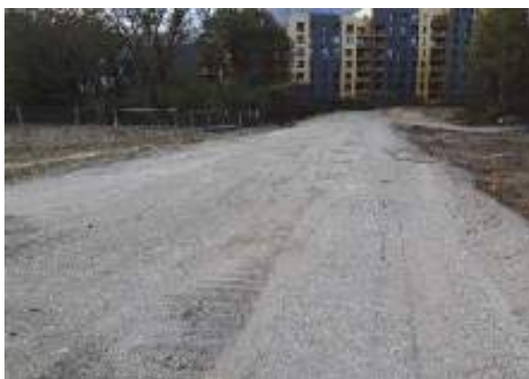
Délimitation physique de la zone de travaux et conservation de la haie côté Ouest (visite du 03/11/2021).
