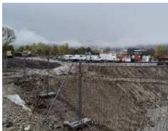
Délimitation physique de la zone de travaux (visite du 03/11/2021)
