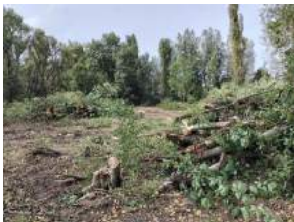
Progression du débroussaillage d'est en ouest (visites du 08 et 15/09/2021)
