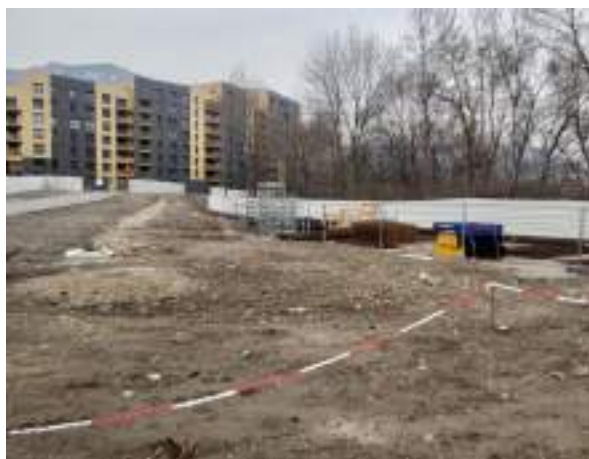
Délimitation des emprises par des barrières en tôle (visite du 16/03/2022)
