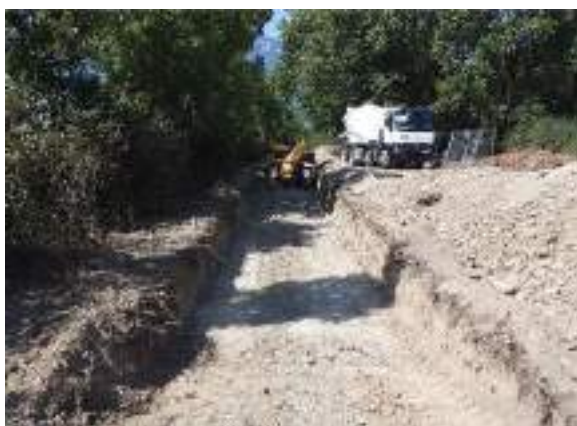
Ouverture de la tranchée pour les réseaux (visites du 08 et 15/09/2021)
