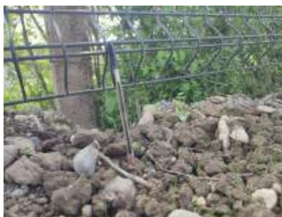
Surélévation des clôtures (visites du 04/04/2024)
