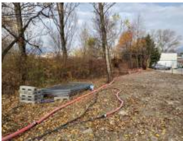
Stockage en limite d'emprise au démarrage du chantier (visite du 24.11.2021)
