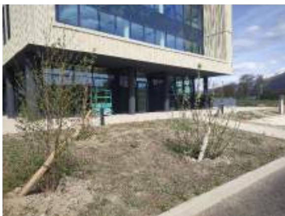
Plantations des espaces verts autour du bâtiment d'Artelia (Visite du 04/04/2024)
