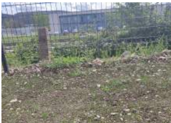
Surélévation des clôtures (visite du 04/04/2024)
