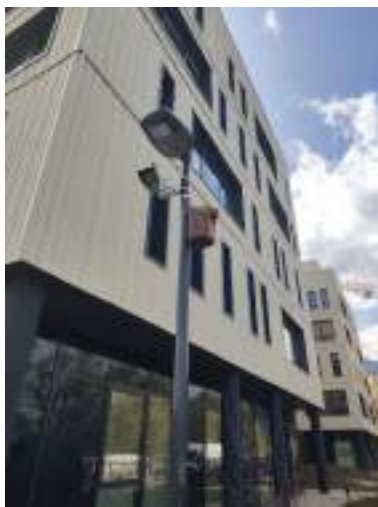
Mise en place d'un éclairage urbain responsable (visite du 04/04/2024)
