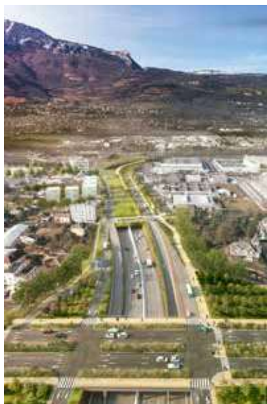
L'échangeur du Rondeau sera aménagé et une couverture végétalisée de 290 mètres sera créée sur la Rocade Sud.
