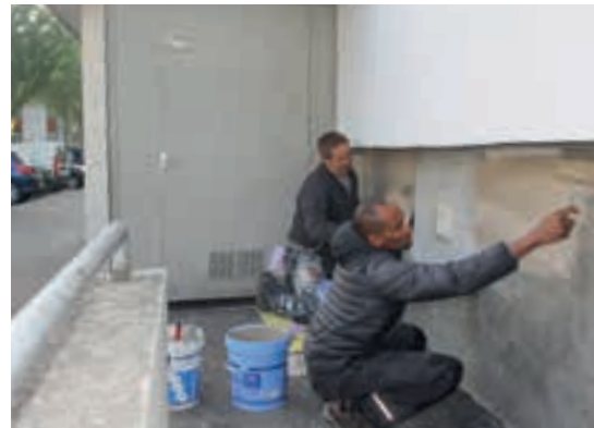
Démarré en octobre, le chantier de peinture des soubassements des barres d'immeuble de la SDH au Village Sud a permis l'embauche en CDD d'un jeune du quartier.
