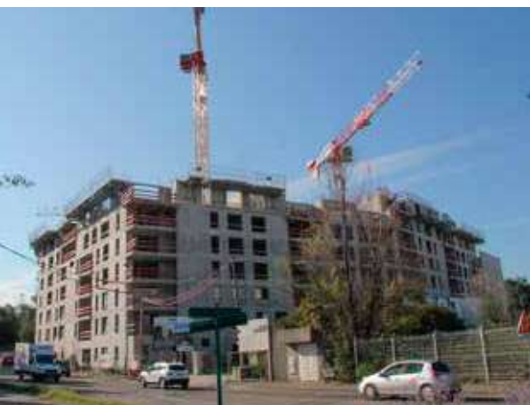
Le chantier de la résidence Golden Parc est la première opération de la Centralité Sud, en attendant les projets sur les sites d'Artelia et d'Atos.
