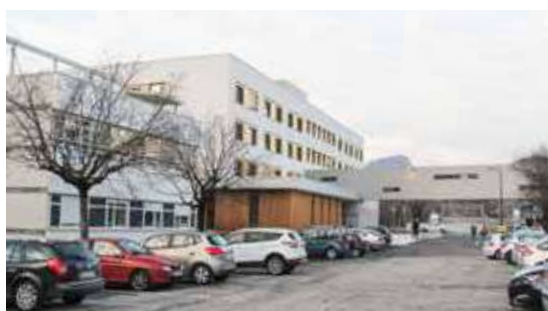
Une passerelle relie le Centre de gériatologie Sud à l'hôpital Sud.
