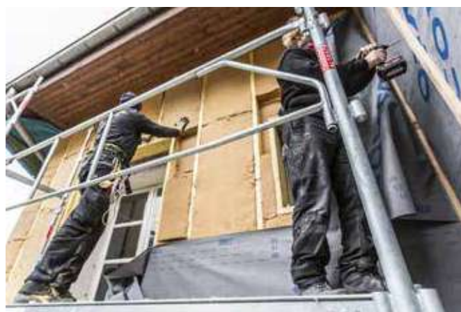
Le dispositif Mur/Mur aide les propriétaires à se lancer dans des travaux d'amélioration de la performance énergétique de l'habitat individuel ou collectif.
