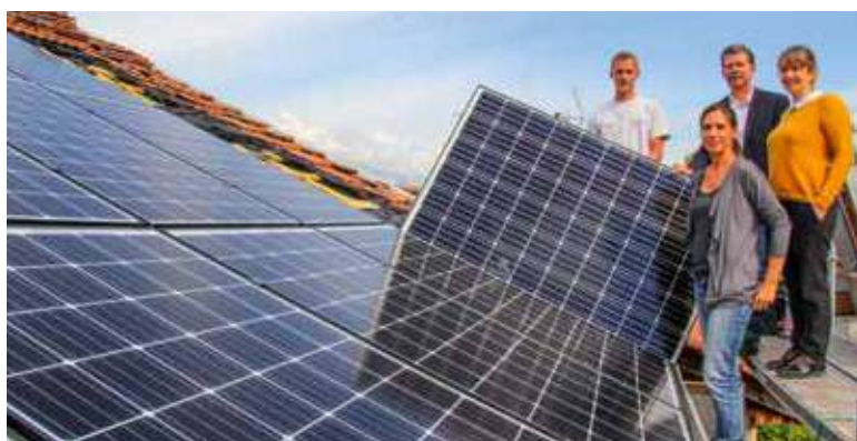
Cette première installation générera une production de 8 kwatts/h d'électricité verte, soit la consommation de 1 à 2 logements.
