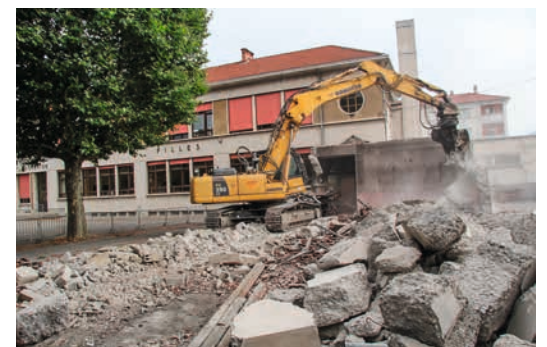
Place nette ! La construction du nouveau restaurant scolaire Vailant-Couturier débute ce mois-ci. 425 000 euros y sont consacrés.
