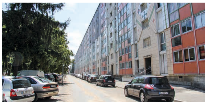
Les rues des Grottes de la Luire et Vassieux ainsi que les impasses Danielle-Casanova vont être rénovées. Des dispositifs ralentiront la circulation.
