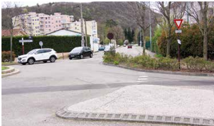
Le plan de circulation a été adapté aux travaux : à Echirolles, les rues de l'Industrie et de la Paix sont particulièrement concernées.
