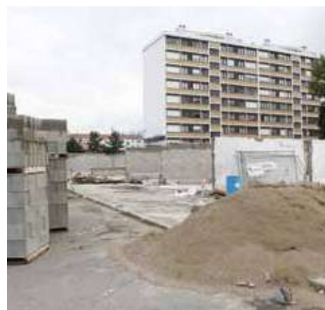
Après de longs mois de suspension, le chantier doit pouvoir redémarrer.
