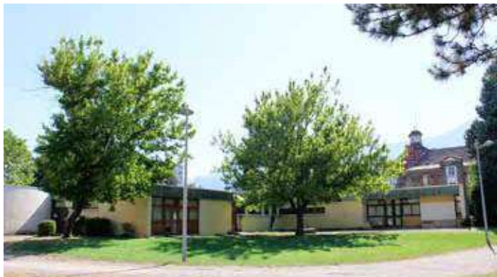
La première phase de travaux devrait être achevée à l'été 2018, suivie, à l'automne, de la démolition du centre social actuel.
