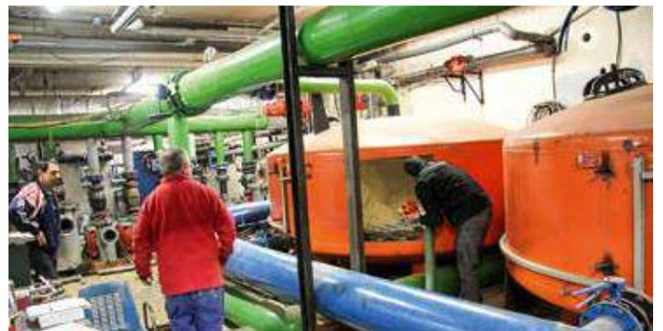
Le système de filtration du bassin extérieur de 50 mètres – filtres à sable, tuyauterie – a été entièrement remplacé.
