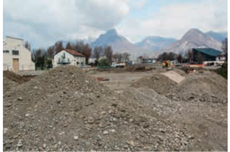
Les travaux de terrassement et de réseaux de la phase 1 du projet Navis ont démarré depuis le début de l'année. Une deuxième phase suivra.
