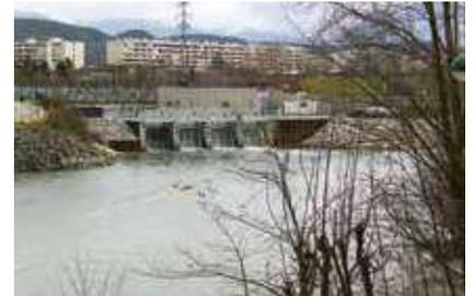
Actuellement en phase d'essai afin de contrôler le fonctionnement des quatre turbines d'une puissance totale de 2 200 kW, l'ouvrage produira à terme 13,7 gigawattheures, soit l'équivalent de la consommation électrique de 5 700 habitants. C'est la première centrale EDF en France à bénéficier d'une telle puissance avec des turbines spécifiques (VLH, very low head) pour de très basses chutes.
