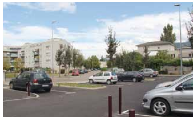
Une vingtaine de places de stationnement ont été créées à l'entrée du quartier.
