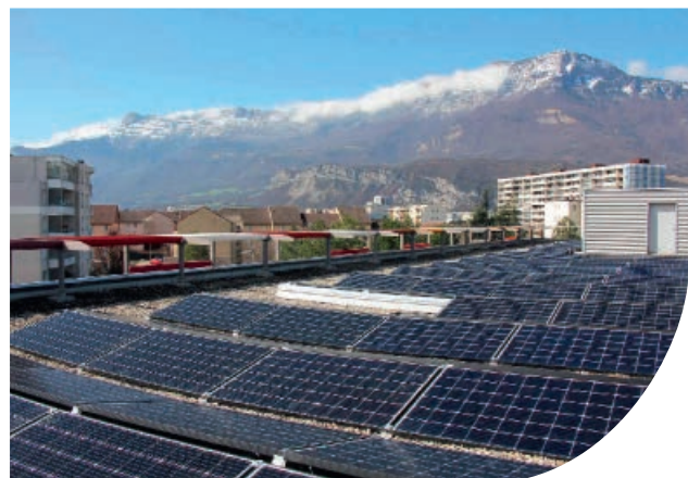
Les panneaux solaires de l'hôtel de ville fournissent désormais 30 % de l'énergie consommé par le bâtiment.
