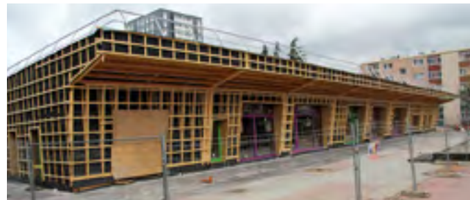
Multi-accueil Les Lucioles au Village Sud, en cours de construction / 2017
