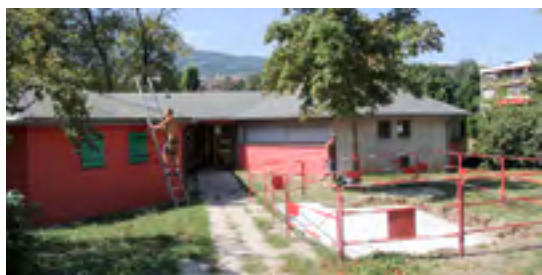
Chantier en cours de la crèche de La Farandole / 2016
