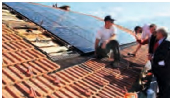
Le maire Renzo Sulli a visité le chantier à la Ponatière.
