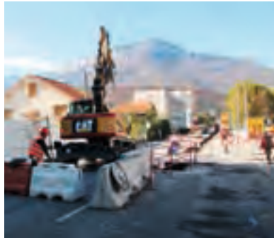
Prolongement du réseau de chauffage urbain sur l'avenue Paul-Vaillant-Couturier.
