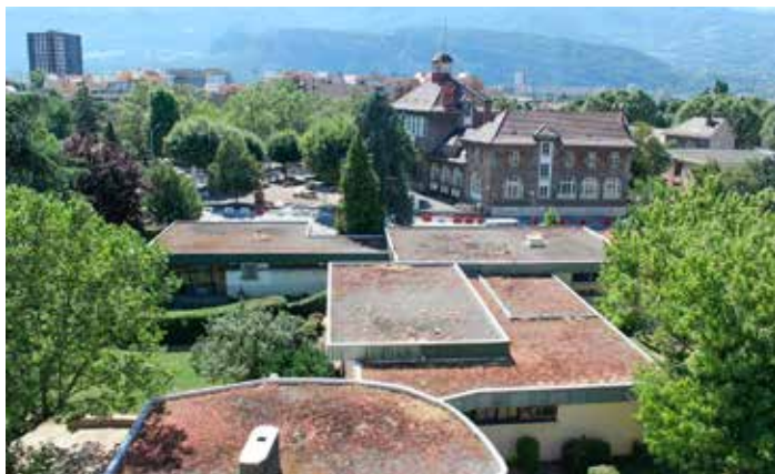
Le site des Ecureuils, face à l'ancienne mairie.
