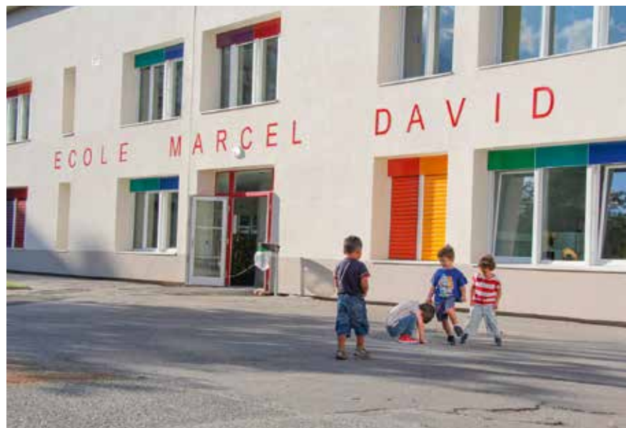
Les écoles vont progressivement être mises aux normes d'accessibilité.
