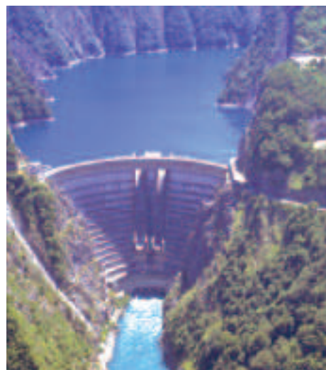
Le barrage de Monteynard, un des six grands barrages de la région
