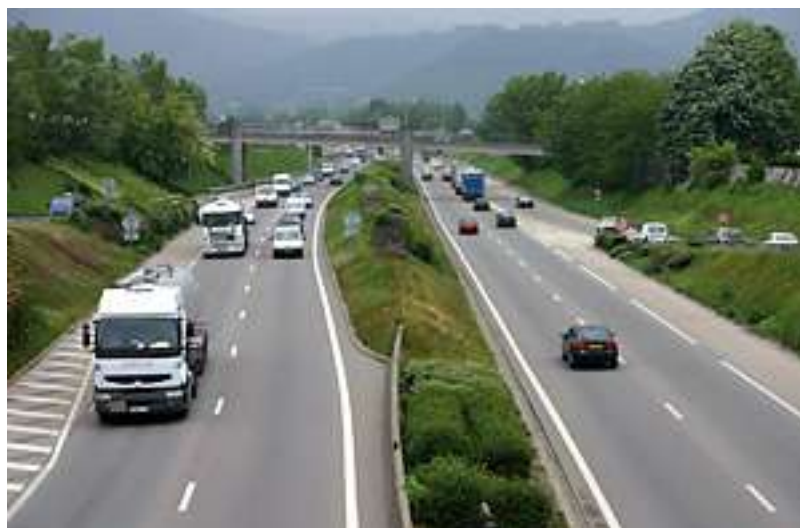
La rocade Sud, axe majeur de transit de matières dangereuses.
