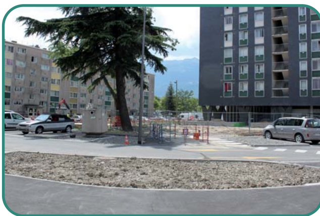
Les travaux de réhabilitation se poursuivent dans les logements du quartier, tout comme les travaux de résidentialisation en pieds d'immeubles.
