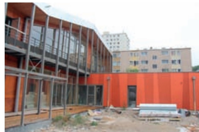
Au Village 2, l'équipement mutualisé, futur pôle jeunesse et centre social, le multiaccueil petite enfance et la rénovation des façades par la SDH marqueront l'achèvement progressif du projet de renouvellement urbain initié en 2008.
