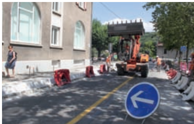
Le nouveau terminus de la C3 a été réalisé cet été : deux arrêts autour de la Maison des associations et du futur Centre du graphisme, aménagement de cheminements piétonniers sécurisés et d'une zone de régulation pour trois bus à l'arrière du bâtiment.
